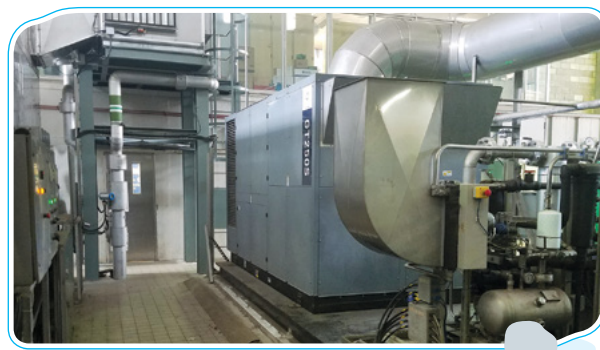
沙田污水處理廠的渦輪發動機 Gas-turbine at Shatin STW
