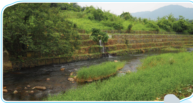
林村河上游堤岸的石籠河岸 Gabion banks in Upper Lam Tsuen River
