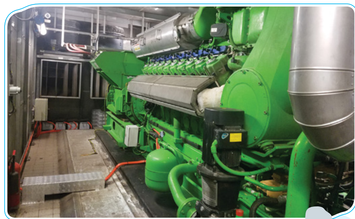
沙田污水處理廠的電熱聯供發電機 CHP generator at Shatin STW
