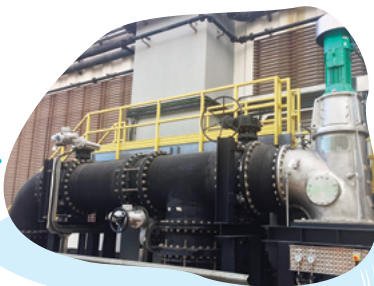
昂船洲污水處理廠的水力渦輪發電系統 Hydro-turbine system at SCISTW
