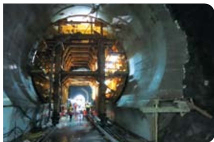
建造污水隧道壁組件 Construction of effluent tunnel lining
