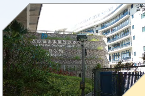
荔枝角雨水排放隧道
