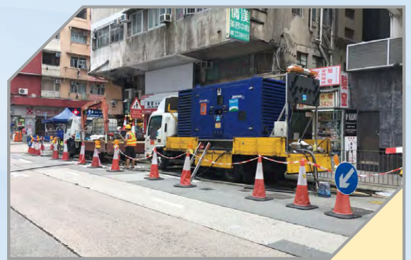
於紅磡船澳街使用高流量水壓車清理渠道
