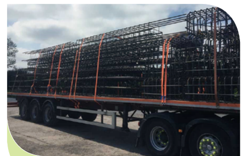
工程項目將會採用預製鋼筋技術
