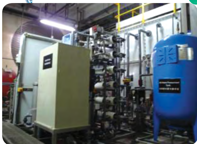
赤柱污水處理廠的逆滲透裝置
