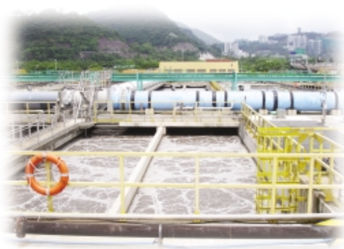
沙田污水处理厂采用更具效益的曝气系统
