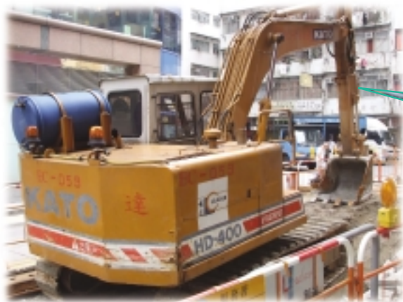
承建商合乎环保做法的好例子——在进行挖掘工程时，使用有洒水装置的挖土机以抑制尘土飞扬的情况
