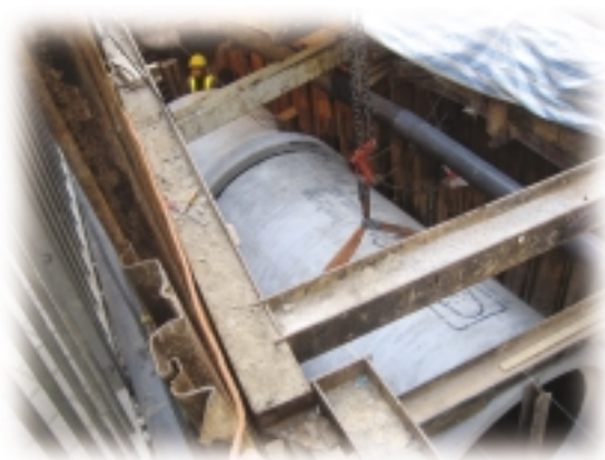
皇后大道中正敷设直径1500毫米的混凝土排水管，以解决上环的水浸问题
