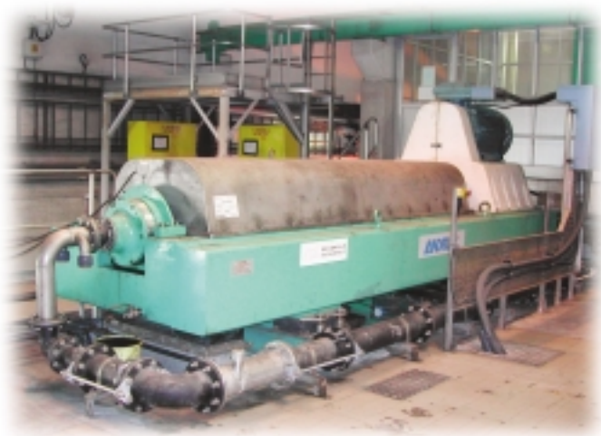
昂船洲污水处理厂具节省能源特点的新型离心机
