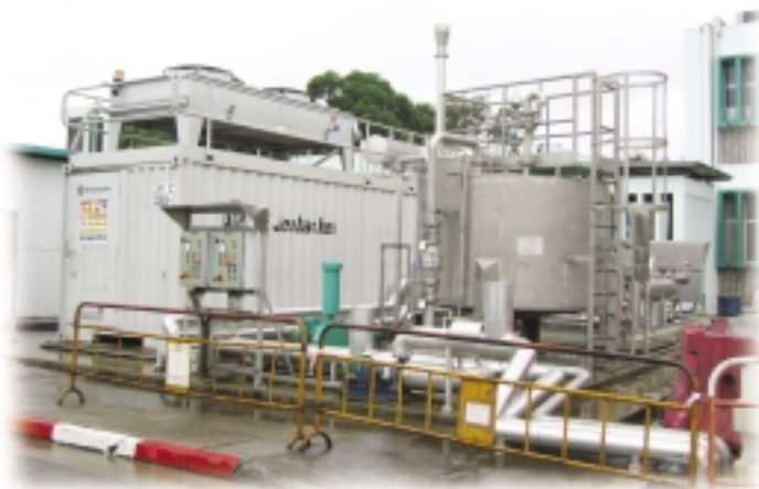
石湖墟污水处理厂电热联供沼气发电机
