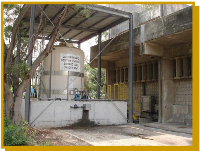
在沙田污水处理厂使用硝酸钙溶液，减低气味。
