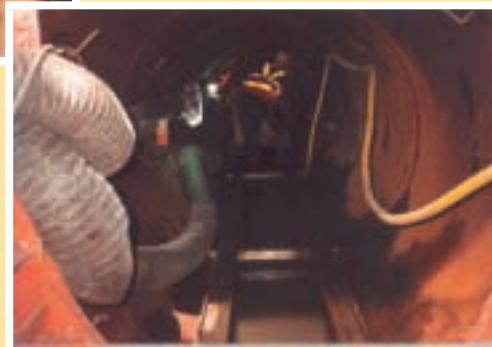
在皇后大道西進行的頂管方法敷設管道工程 Pipejacking works inside sleeve pipe at Queen's Road West
