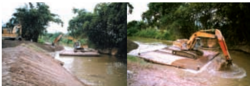
地區性改善工程—河岸穩固工程（左圖）和清理淤泥工程（右圖） Local improvement works - bank stabilization (left) and desilting (right)
