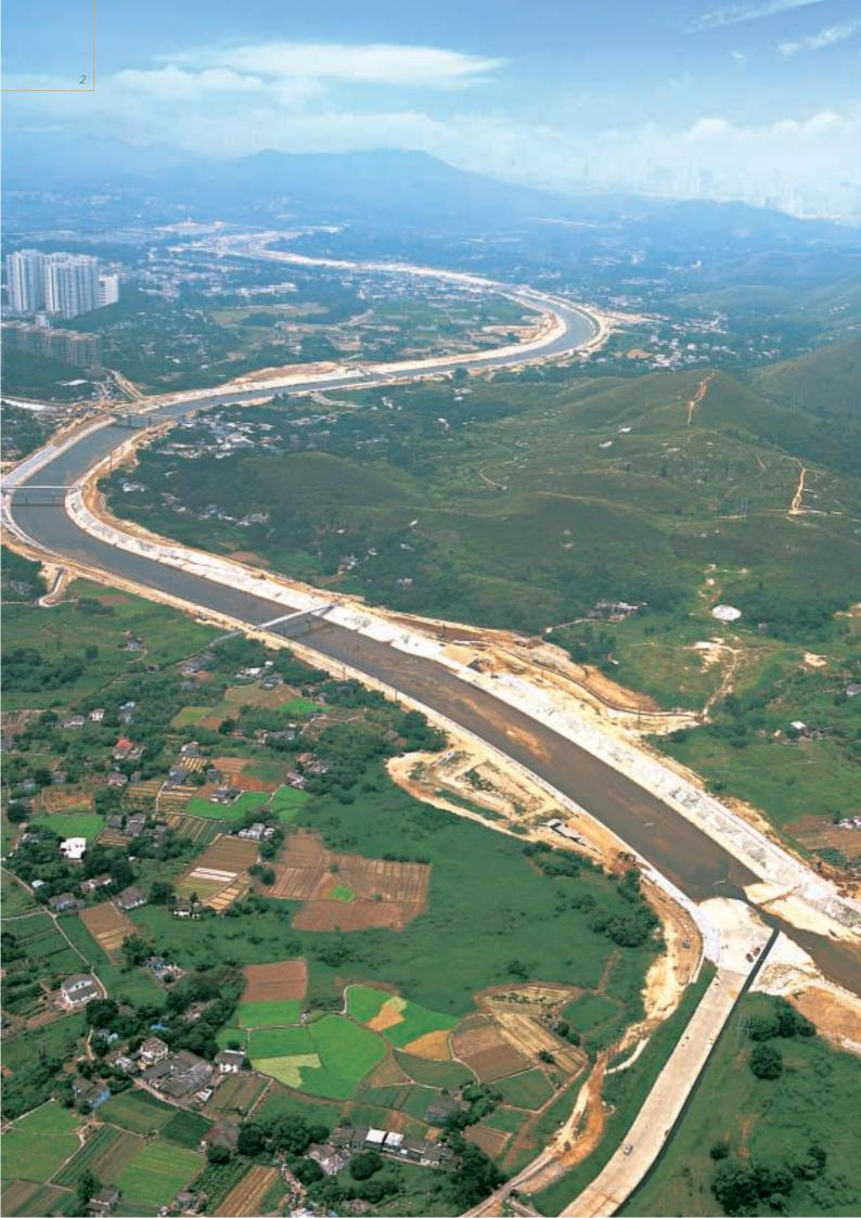
為了解決水浸問題,我們正在新界進行大型治河工程及鄉村防洪抽水計劃,及在西九龍進行雨水排放系統改善工程以提高西九龍的防洪能力。至2003年年底,我們已完成總值65億元的工程,並將於未來數年繼續投資63億元以完善排水設施。另外,我們正策劃一系列雨水排放系統改善計劃,以提高全港各區的防洪能力。
