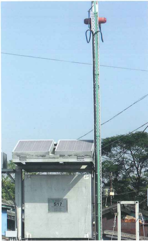
洪水警告響號系統的警報器
