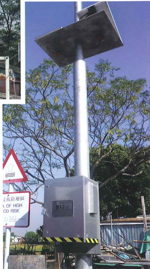
洪水警告響號系統的感應器及控制箱
