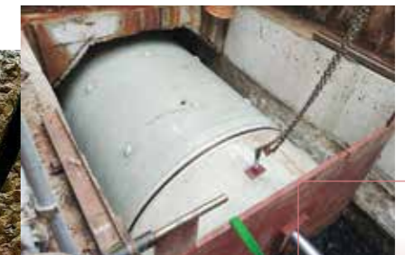
渠道修復工程 Rehabilitation works
