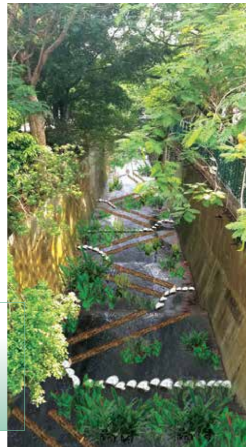
佐敦谷明渠魚梯的 構想圖 Photomontage of Fish Ladders at Jordan Valley Nullah
