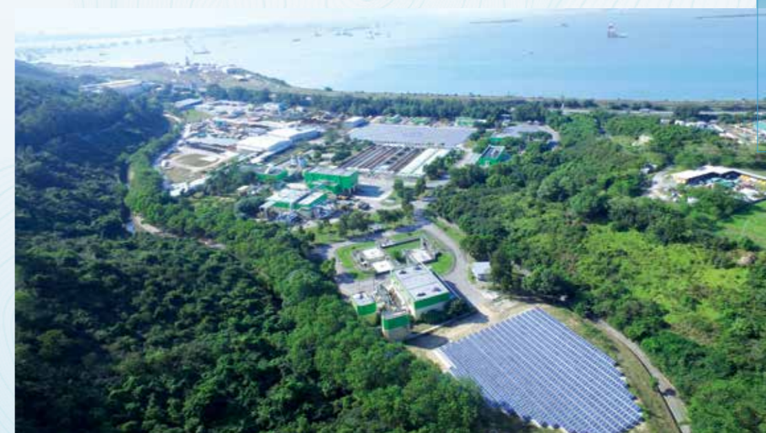
小蠔灣污水處理廠 Siu Ho Wan Sewage Treatment Works
