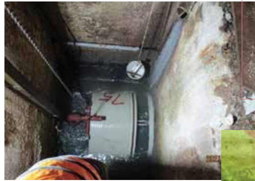
渠道修復工程 Rehabilitation works
