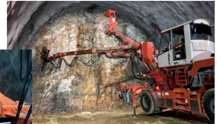
使用鑿岩台車鑽挖炸藥孔 Using the drilling jumbo for blast hole drilling
