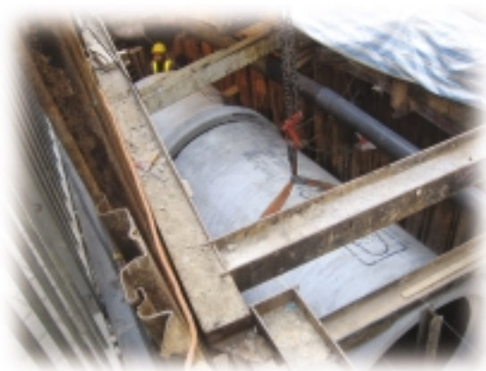
皇后大道中正敷設直徑1500毫米的混凝土排水管，以解決上環的水浸問題
